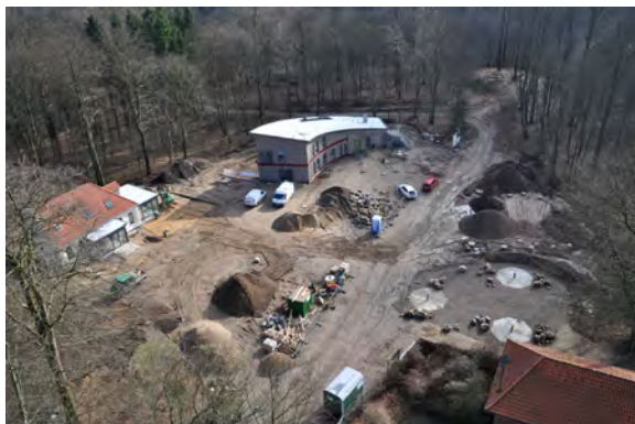
Blick auf die Baustelle vom Fernsehturm aus
