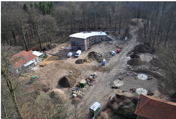
Blick auf die Baustelle vom Fernsehturm aus
