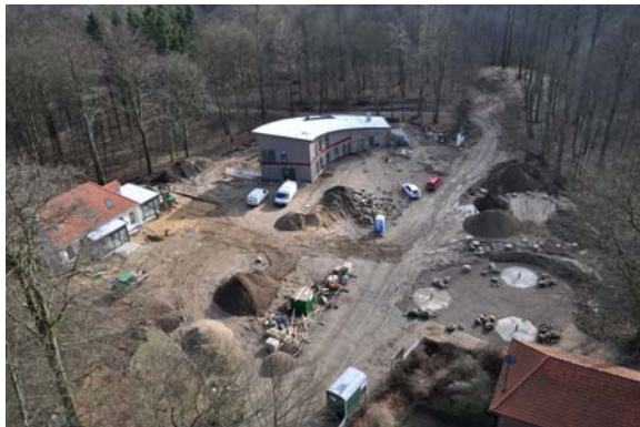
Blick auf die Baustelle vom Fernsehturm aus
