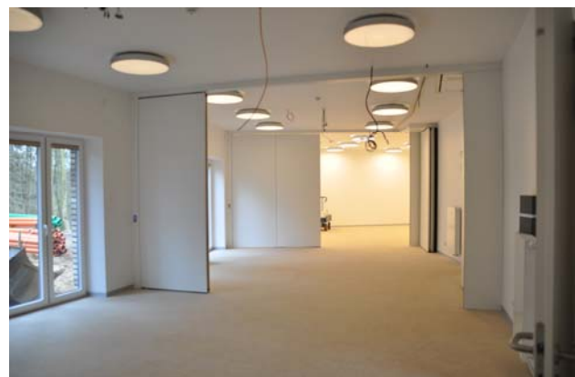
3 Schulungsräume mit mobiler Trennwand im Untergeschoss
